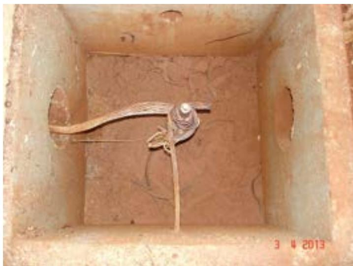
Figura 29 - Solda FOSCOPER NÃO DEVERÁ ser aceita nas conexões de aterramento.
