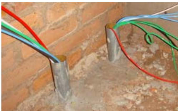
Figura 11 - Saída de fiação em eletroduto
