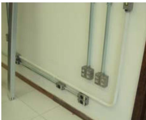
Figura 12 - Fixação de condutores
