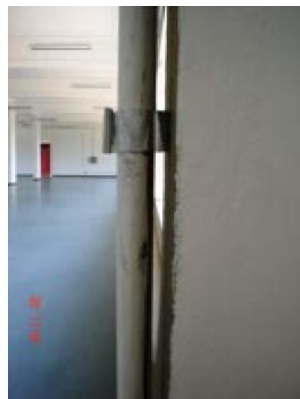
Figura 4 - Pintura de eletrocalhas, perfilados e eletrodutos
