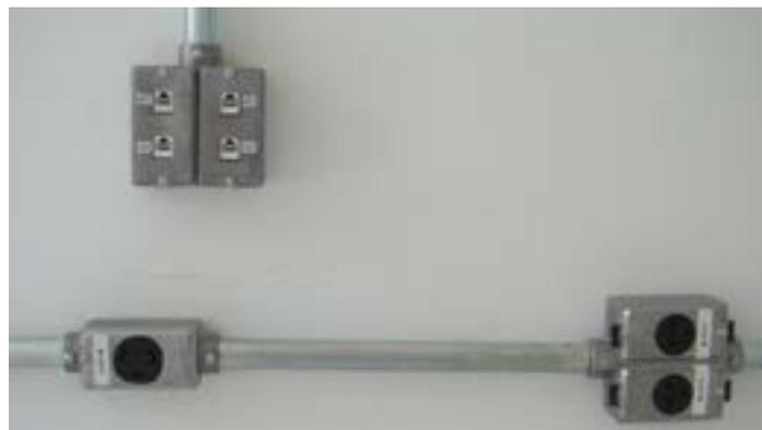
Figura 9 - Fixação de condutes
