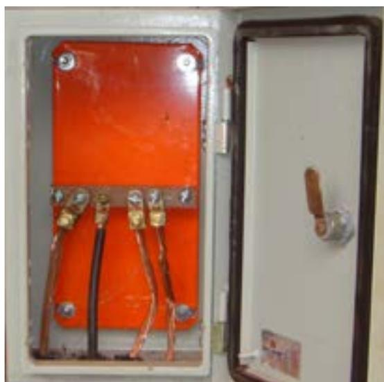
Figura 36 - Caixa de equalização dos aterramentos
