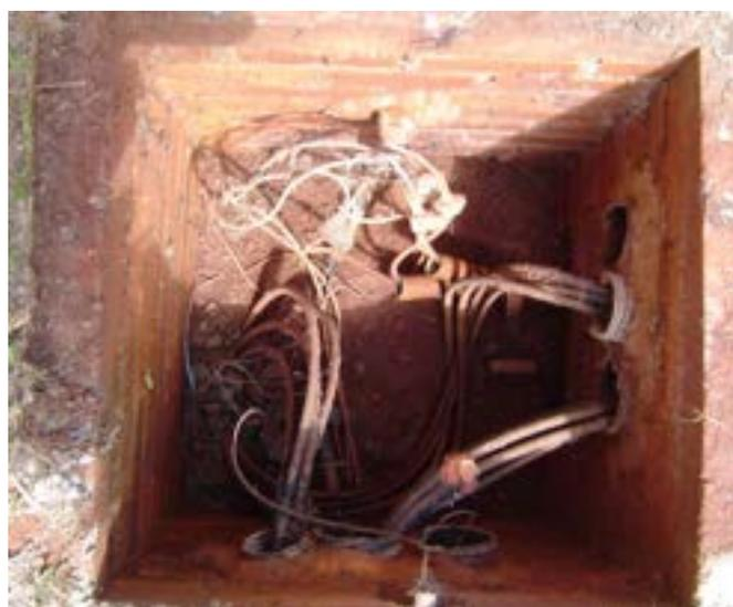
Figura 13 - Caixa de passagem em alvenaria
