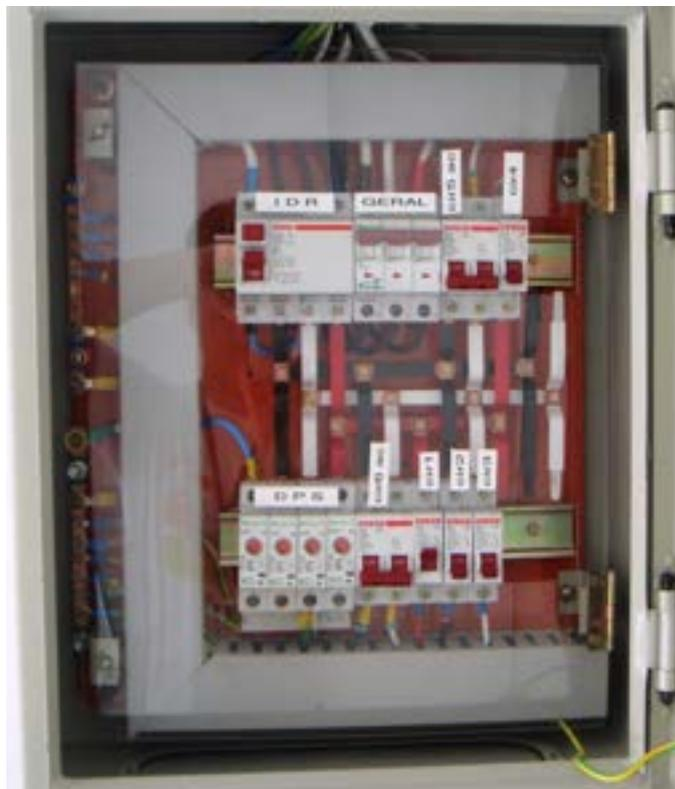
Figura 20 - Identificação dos circuitos nos quadros
