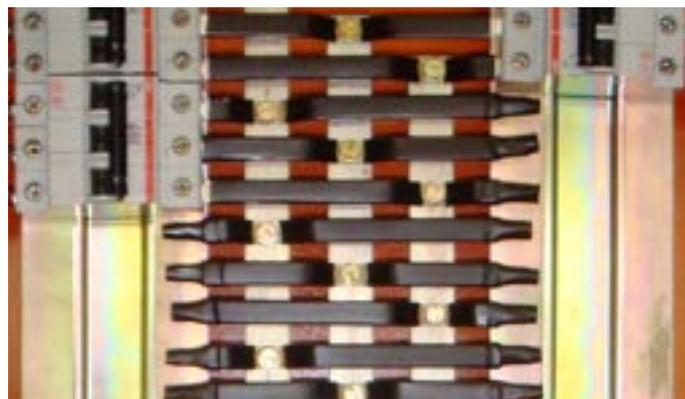
Figura 22 - Derivações dos circuitos
