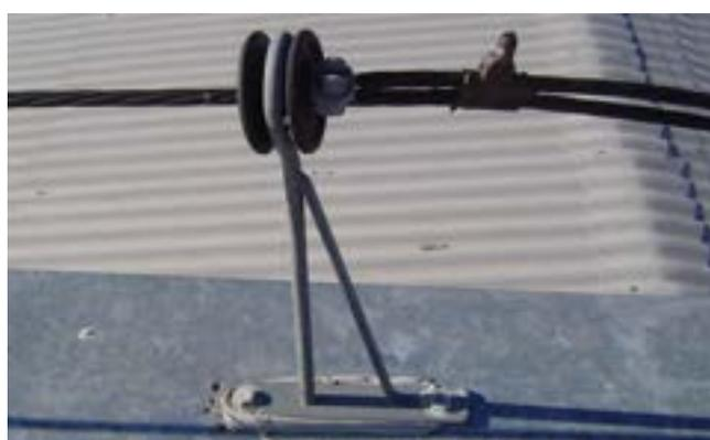
Figura 34 - Fixação dos condutores de descida do SPDA da cabos da malha sobre o rufo (sem contato entre o cobre e o zinco).
