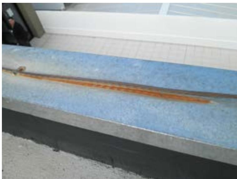
Figura 31 - Corrosão no contato entre o cobre e o zinco. **NÃO ACEITAR** o SPDA nestas condições.
