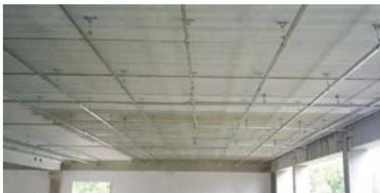
Figura 8 - Fixação de perfilados por tirantes
