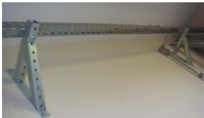
Figura 7 - Fixação de eletrocalhas por mão francesa
