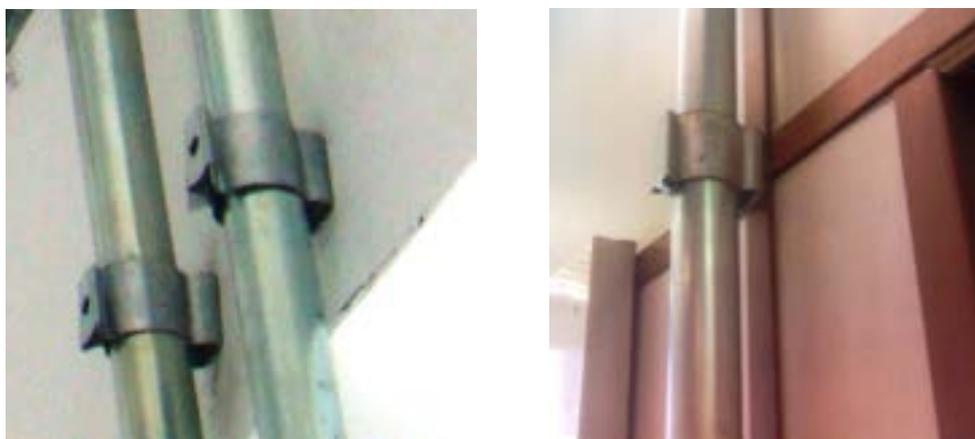
Figura 5 - Fixação de eletrodutos
