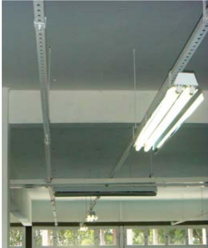
Figura 1 - Perfilado desalinhado
