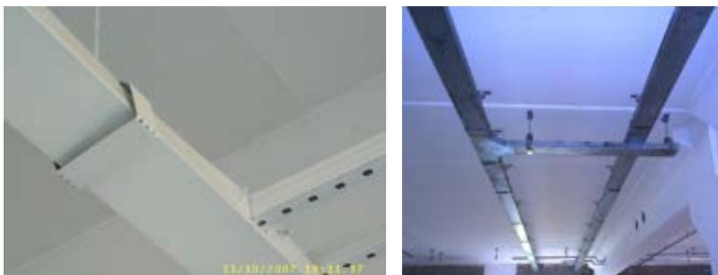
Figura 6 - Fixação de eletrocalhas por tirantes
